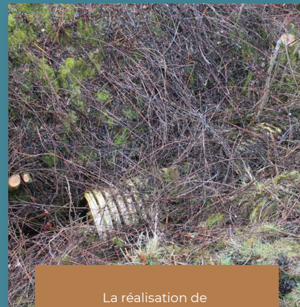
La réalisation de réseaux de drainage
