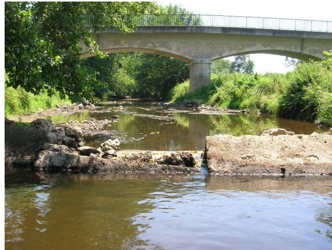
Seuil jaugeur de Prissac
