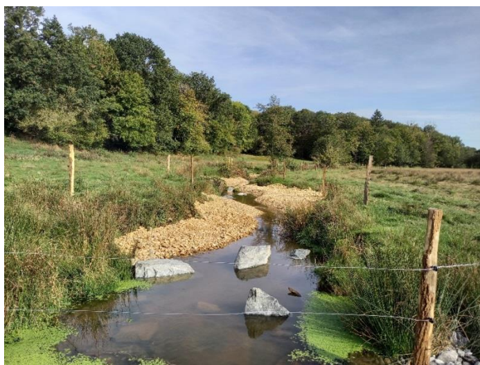
Travaux de restauration du lit et de mise en défens sur l'Anglin
