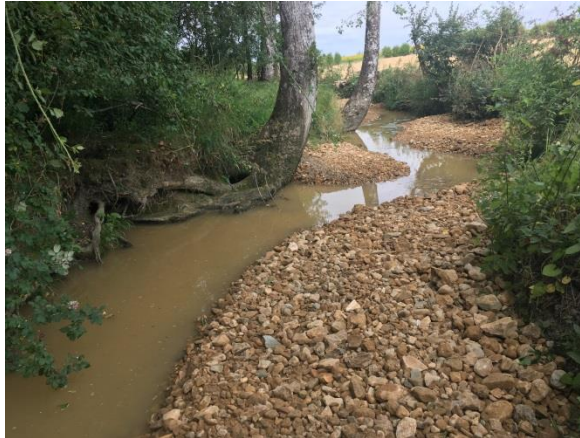
Travaux de restauration de l'Aigronne
