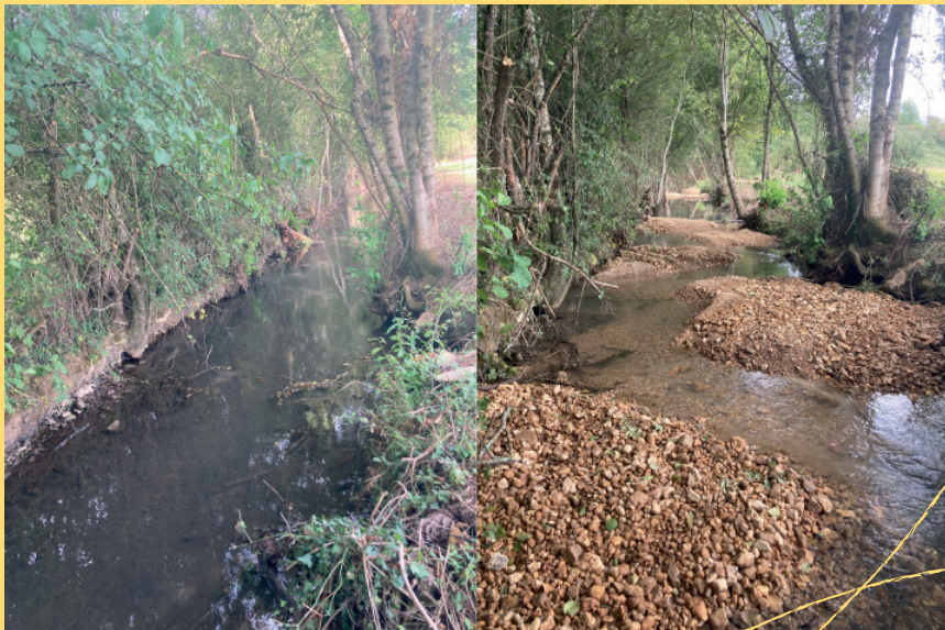
avant/après travaux sur le Bouzanteuil
