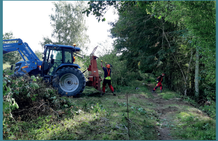
Restauration de la ripisylve
