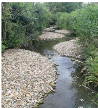
Travaux de restauration du lit de l'Aigronne
