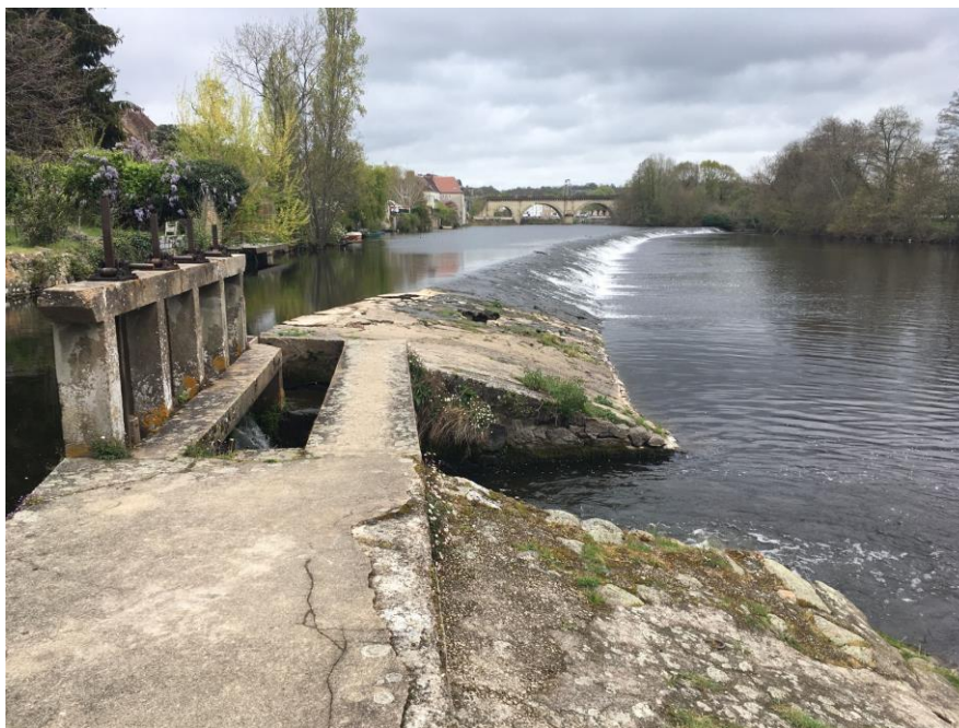
Seuil du Moulin du Rabois à Argenton-sur-Creuse
