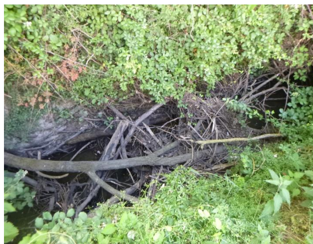
Accumulation de branchages sur le Chambon
