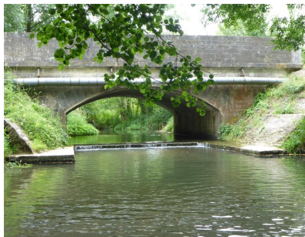
Radier sous pont sur la Claise (pont de la D11 à Vendœuvres)
