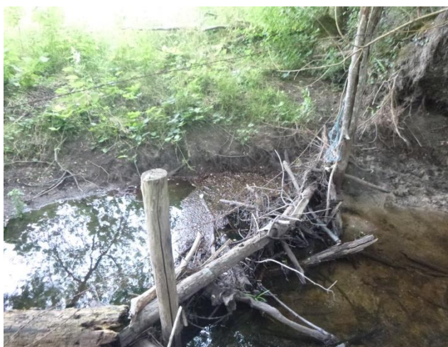
Clôture en travers avec accumulation de branches sur le Marais de la Rompure
