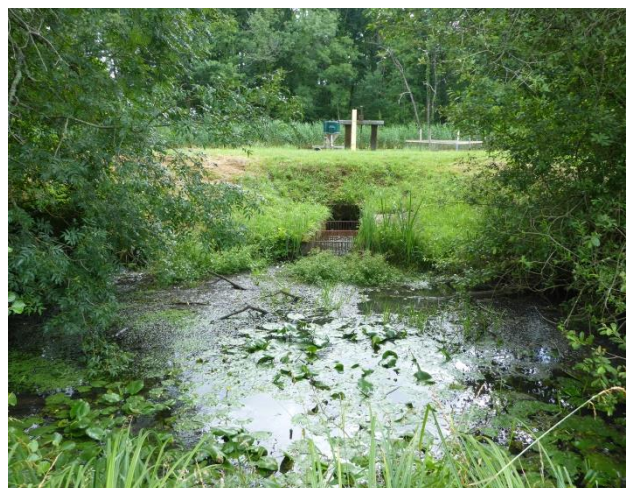
Sortie de plan d'eau avec dégrilleur (Claise amont)
