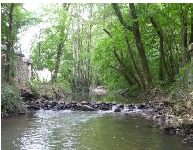
Seuil en enrochement artisanal sur de la Claise (300 m en aval du pont de la D11 à Vendœuvres)
