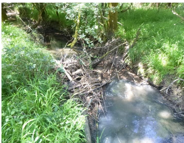
Accumulation de branchages sur le Moury
