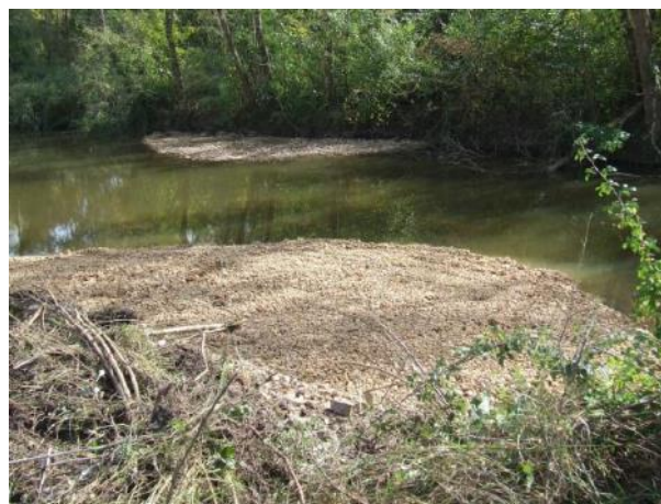
Restauration du lit mineur après suppression d'ouvrage sur la Claise
