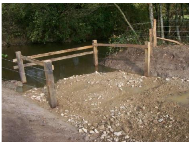
Descente aménagée pour le bétail sur les Cinq Bondes
