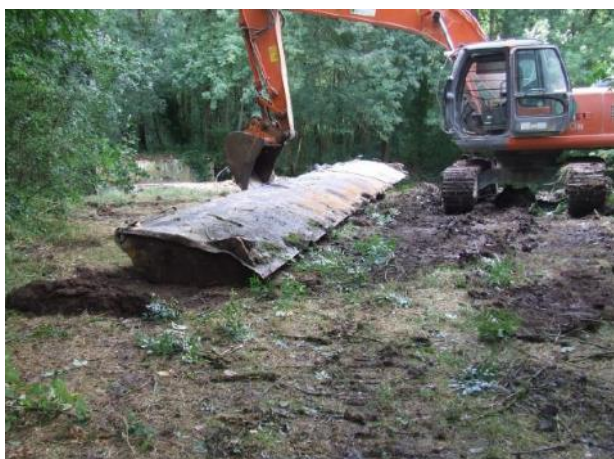
Suppression du clapet CL16 sur la Claise (Mézières-en-Brenne)
