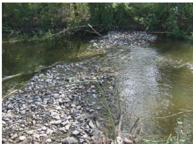
Restauration du lit mineur après suppression d'ouvrage sur la Claise
