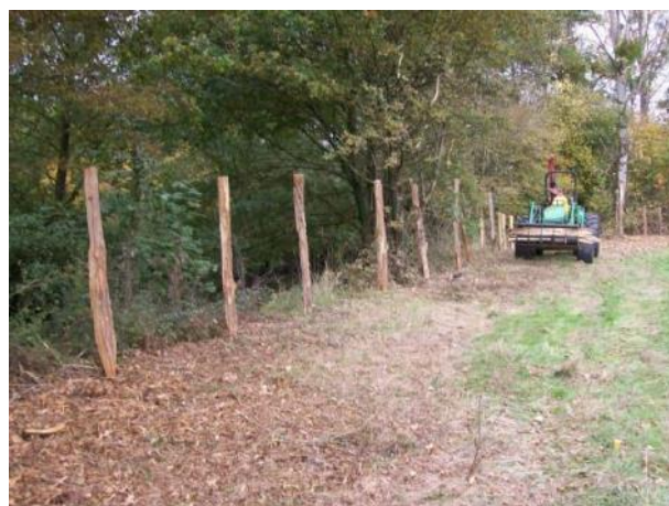
Mise en place de clôtures le long de la Claise
