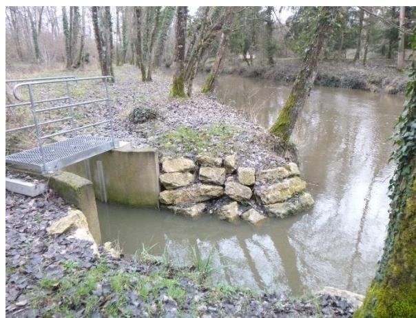
Connexion de la frayère avec la Claise – Passerelle et dispositif de batardeau en dessous
