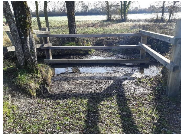
Protection du captage d'eau potable
