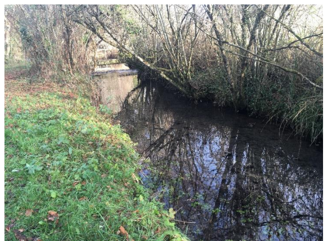
Homogénéisation du milieu et colmatage
