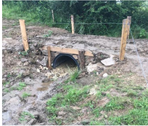
Figure 14 : demie-buse aménagée sur le bassin versant de la Bourbince
