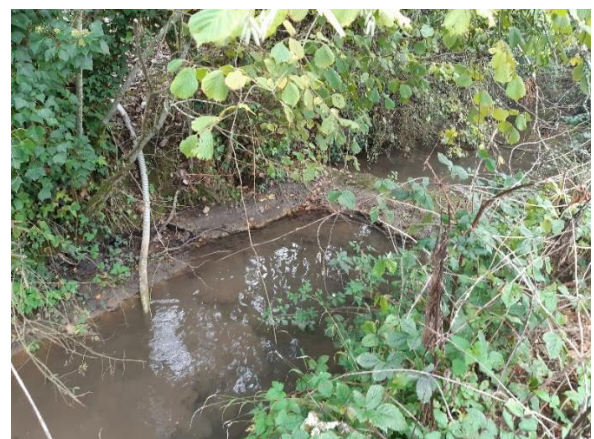
Curage et colmatage
