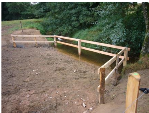
Figure 10 : descente aménagée sur le bassin versant de la Bourbince
