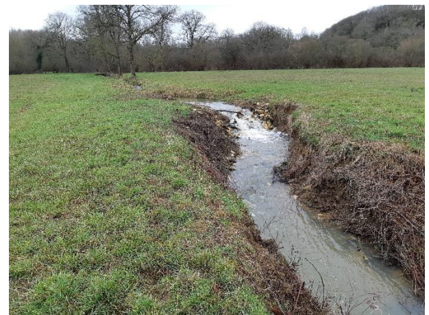
Tronçon aval dégradé
