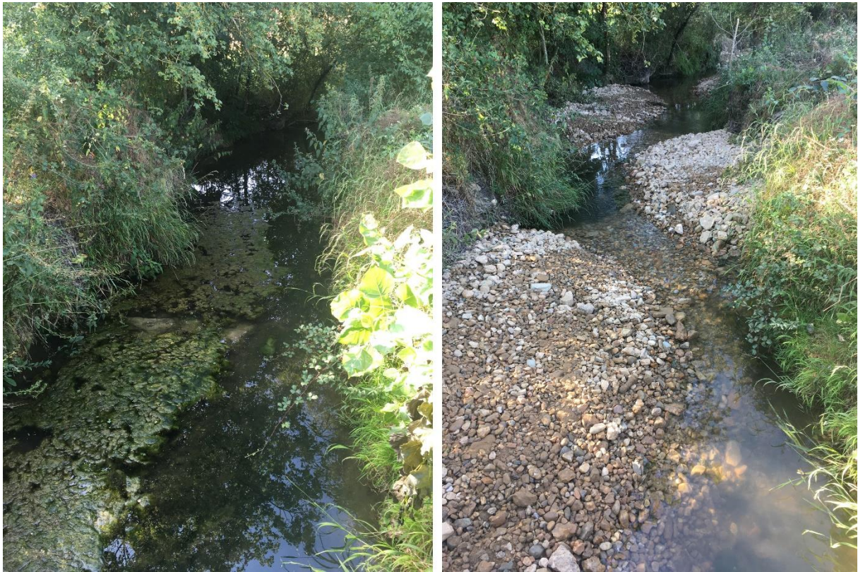
Figure 17 : création de banquettes minérales (avant/après) sur le bassin de la Claise
