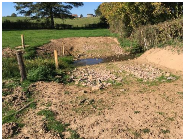
Figure 15 : passage à gué aménagé sur le bassin versant de la Bourbince
