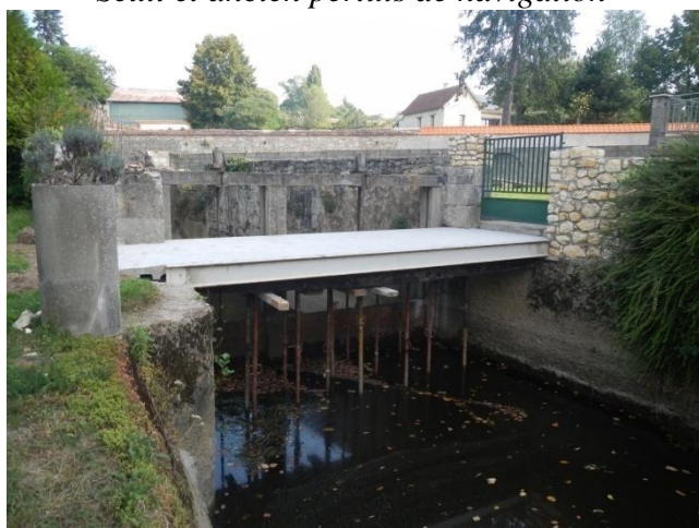
Ancien canal usinier avec ses vannes
