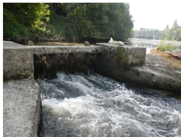
Emplacement des anciennes vannes de décharge
