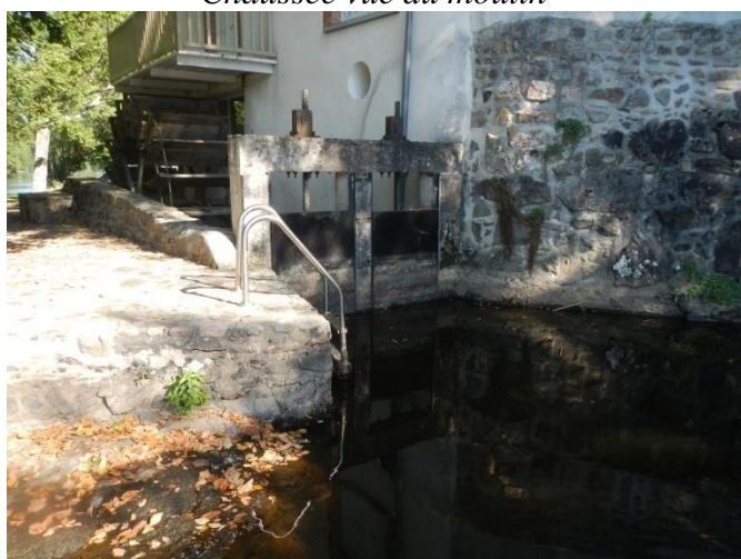
Ancien vannage usinier et ancienne roue
