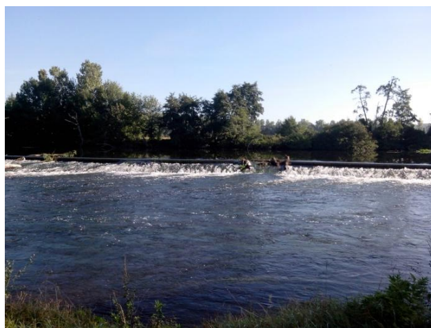
Chaussée vue de la berge de rive gauche
