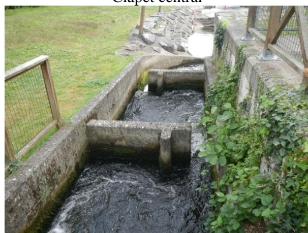
Basse à bassin en RD –exutoire vers le stade d'eaux vives
