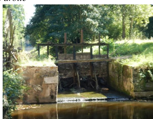
Vannage du bras usinier
