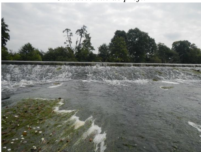
Chaussée vue de l'aval
