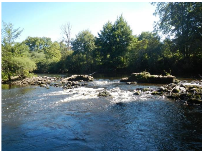
Ancien ouvrage vu de l'aval
