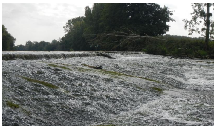
Réhausse du seuil de 30 cm réalisé après la seconde guerre mondiale
