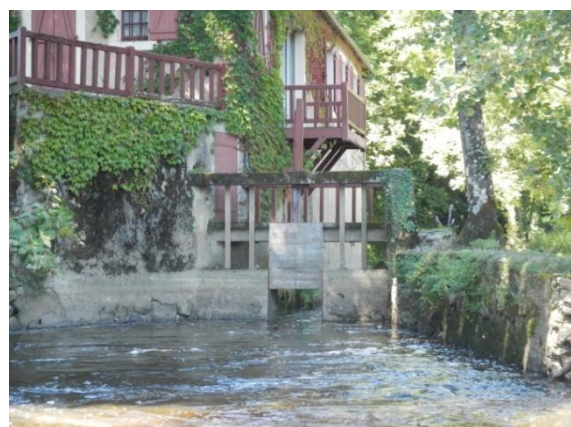
Vannage du moulin de Palis
