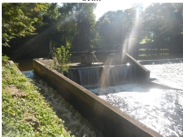
Clapet de décharge (vue aval)
