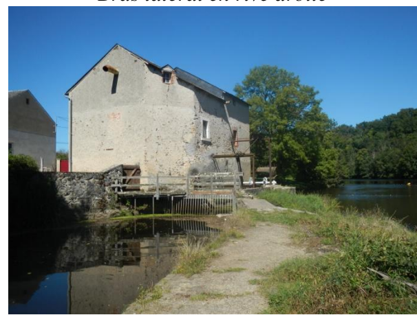
Bâti avec roue accolée (en cours de réfection)
