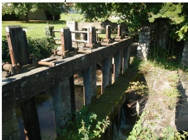
Vannages controlant le bras d'alimentation du moulin du Roc
