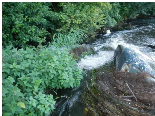
Passé à canoë installée en rive gauche
