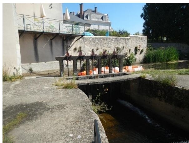
Vannes de décharge du moulin de St Etienne
