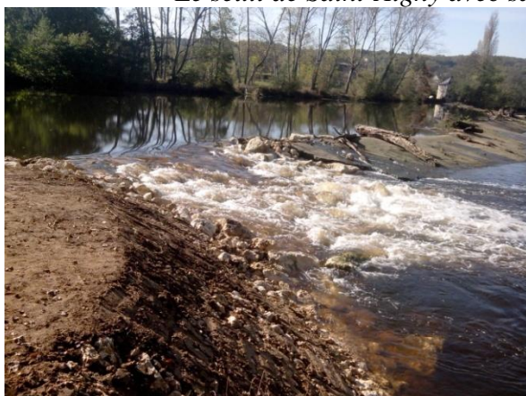
Reprise de la berge et colmatage de la brèche en octobre 2014
