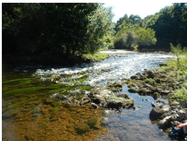
Brèche dans la partie amont de la chaussée
