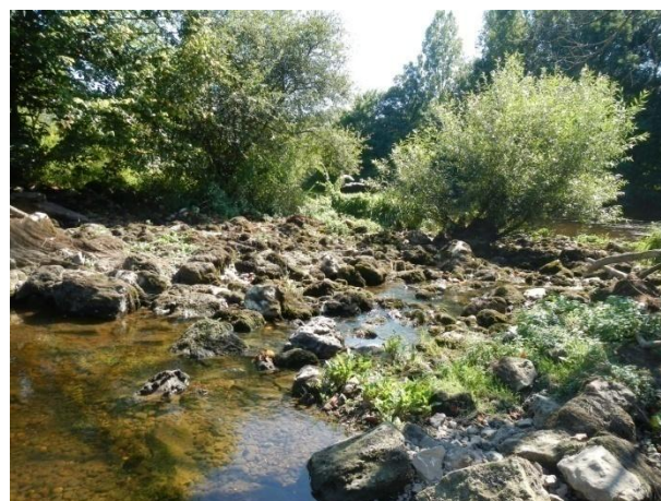
Vestige de la chaussée
