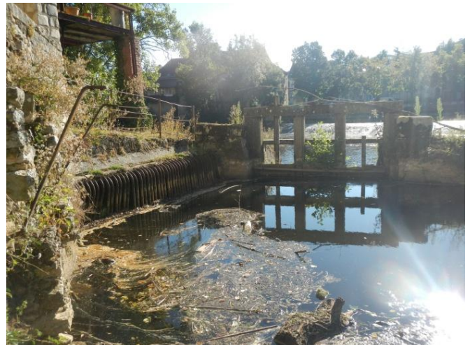
Vannage de décharge du moulin de Varenne
