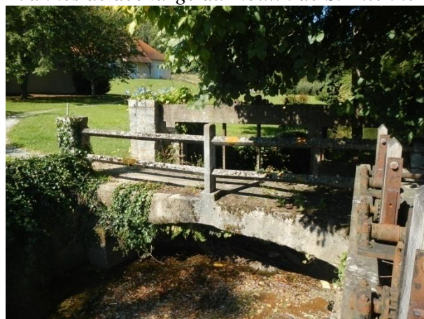
Vannages controlant le bras d'alimentation du moulin du Roc
