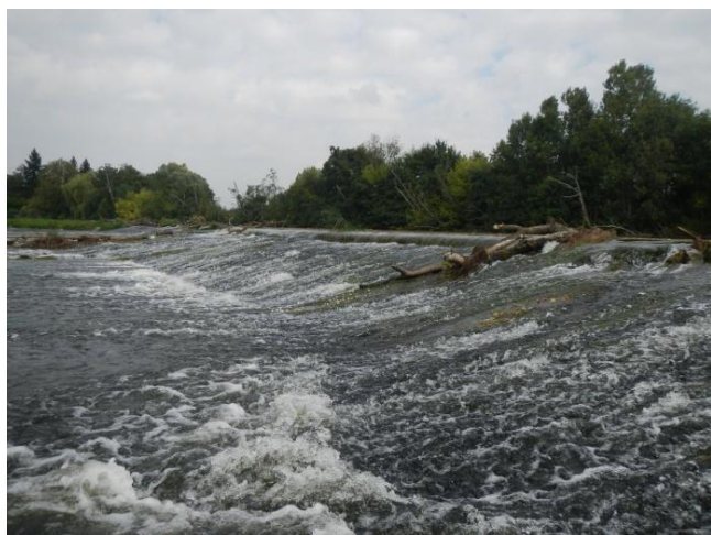
Chaussée vue de profil
