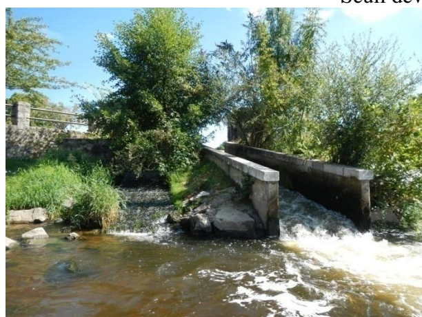
Rampe à anguilles et passe mixte en rive droite
