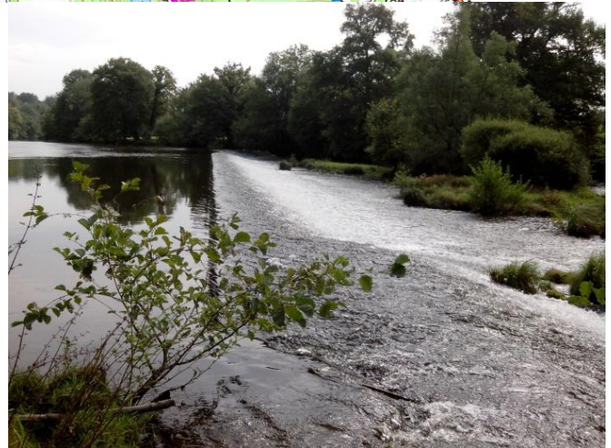
Seuil le 24 septembre 2014
