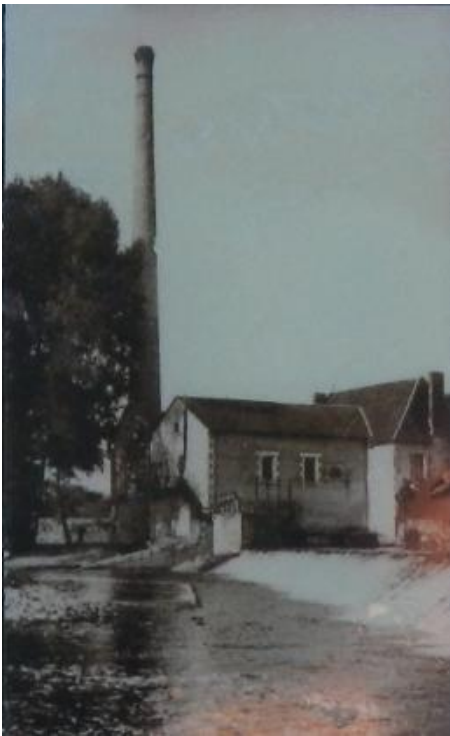
Grande cheminée construite en 1913 et détruite en 1952
