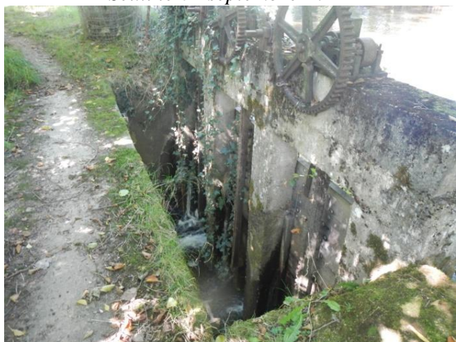
Ancienne vanne de décharge
