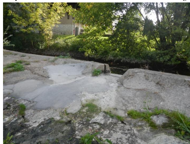
Partie rénovée du déversoir côté moulin
