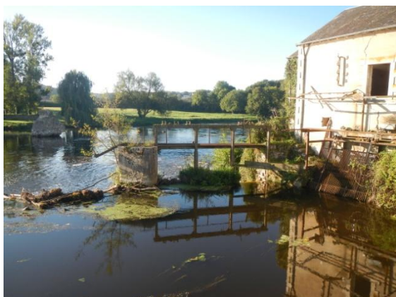
Vannage de décharge
