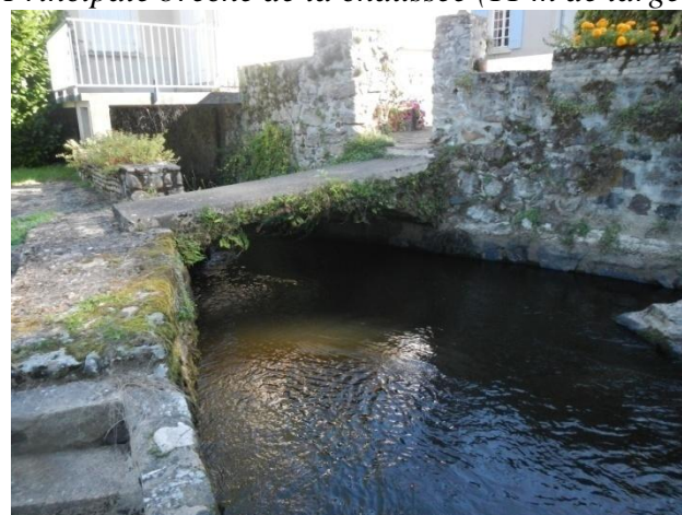
Ancien canal usinier du moulin
