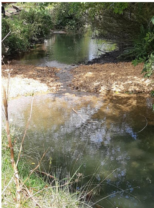
Création d'un radier sur l'Aigronne
