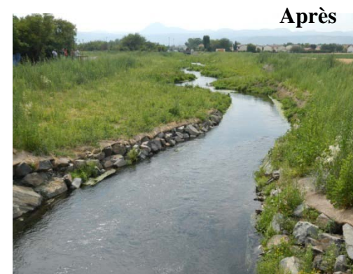
Exemple de travaux de reméandrage sur la rivière Artière, CIAE 2015
