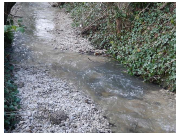
Recharge alluviale réalisée sur la rivière Mauldre, 2015
