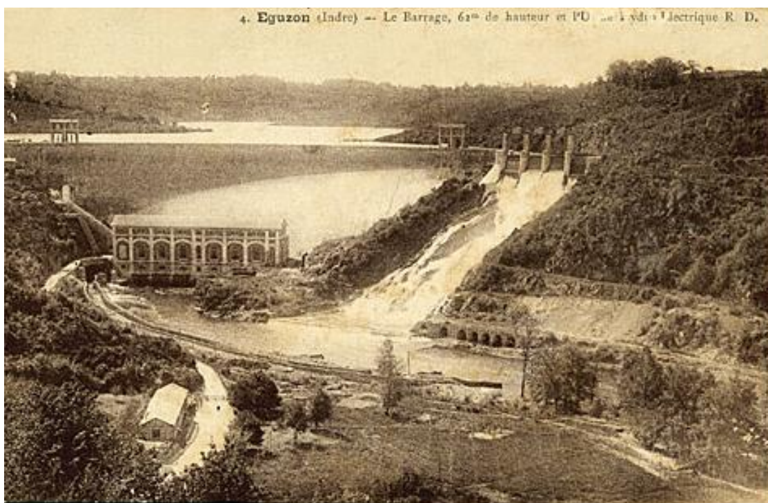
Figure 61 – Barrage d'Eguzon dans les années 30
