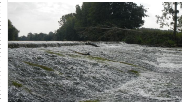
Réhausse du seuil de 30 cm réalisé après la seconde guerre mondiale
