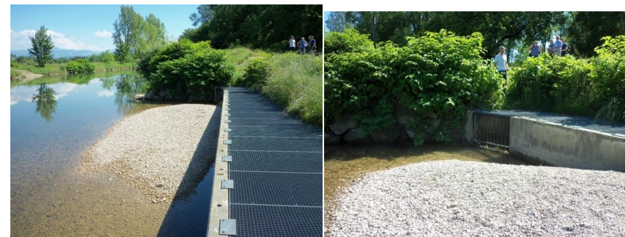
Figure 6 - Engravement d'une passe à poisson sur le Guiers, affluent du Rhône (73)
