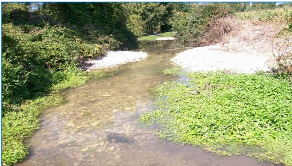
Figure 16 : Photo exemple d'une recharge granulométrique sur le bassin de la Claise
