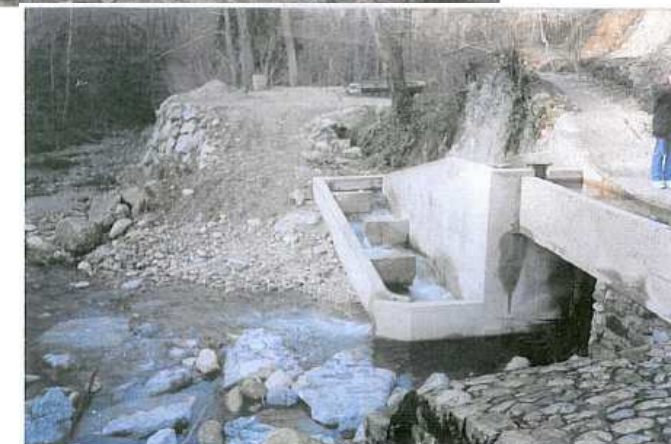
Passe à poissons en fonctionnement
