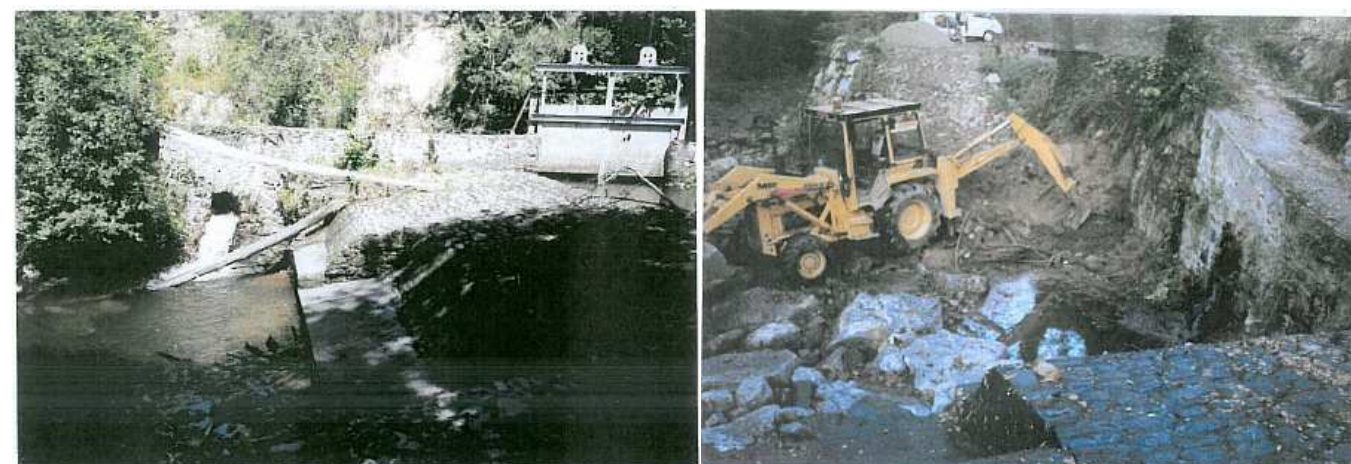
Illustration : Création d'une passe à poissons
