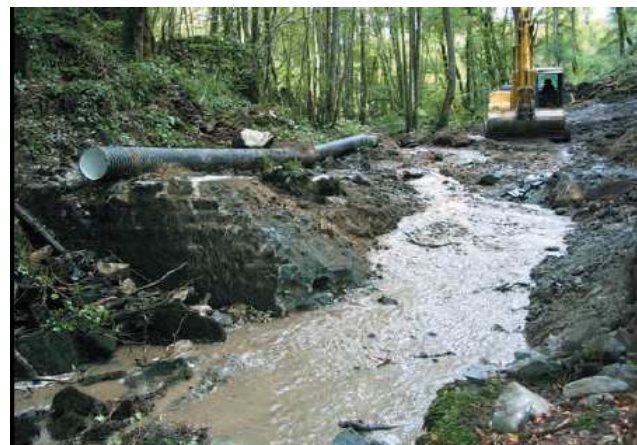
DR - Oriema Le ruisseau de la Maria en octobre 2004, à la fin des travaux de restauration.
