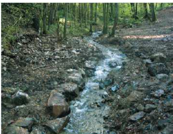
DR - Oriema Le ruisseau de la Maria en 2004, quelques mètres en amont du seuil arasé. Stabilisation des berges par les blocs de la digue du seuil.
