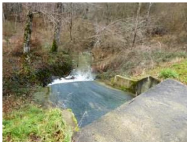
Figure 37 : Déversoir du plan d'eau
