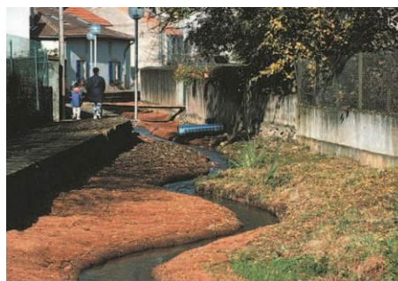
Montvaux, pendant restauration
