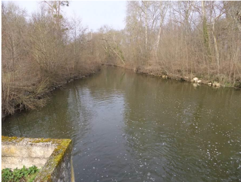
Aval du CL13, Source : SOMIVAL - 21/03/2012
