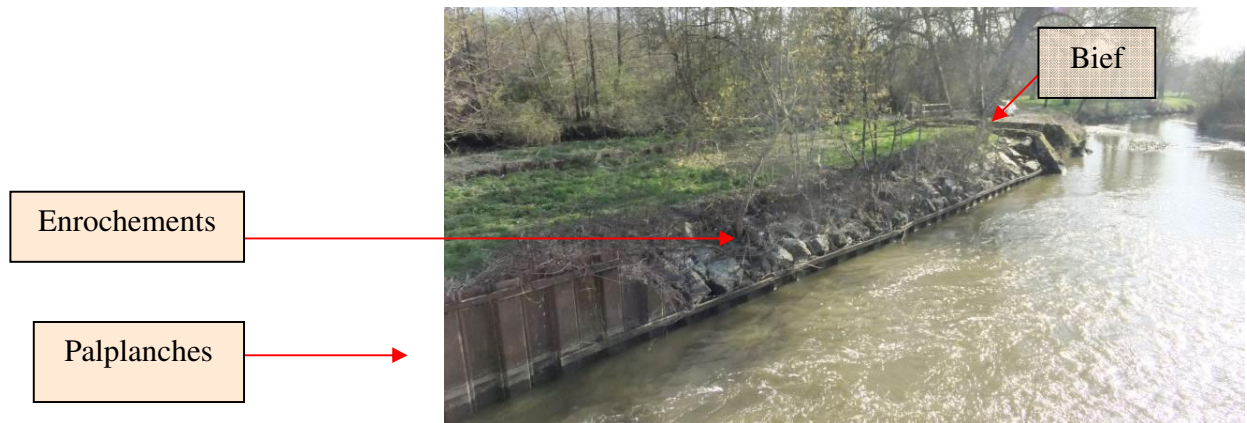
Aval du CL17, Source : SOMIVAL - 29/03/2012
