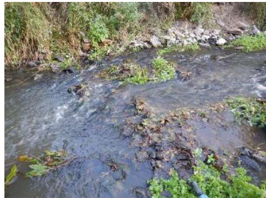
Figure 40 : Radier créé : faciès lotique à granulométrie grossière.
