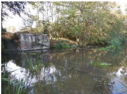
Figure 42 : Ancien ouvrage (en aval de la station) demantelé et arasé.
