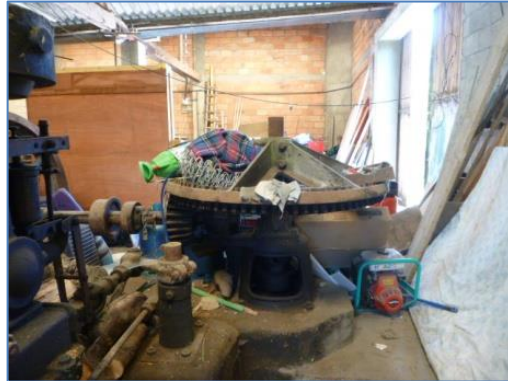
Vues des systèmes de production électriques de Salleron et de Charneuil.
