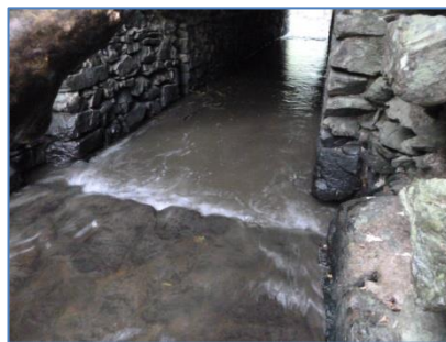
L'emplacement des anciens vannages est encore bien visible dans les radiers en pierres et dans les murs.
