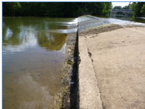
Vues des déversoirs de Charneuil et de Bêlâbre.
