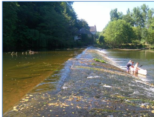
Exemples de blocage du transit des sédiments aux Forges de Gastevine et à Ségère.
